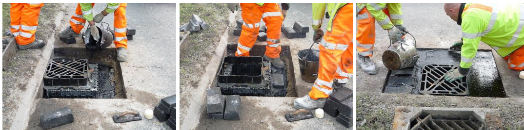
Realizarea umplerii zonei de instalare
