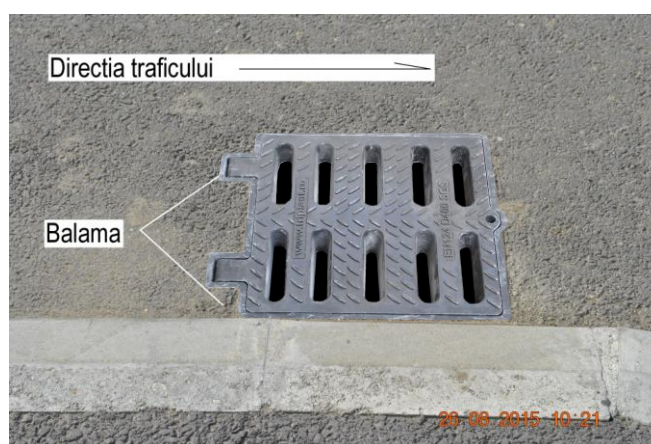
Dupa instalarea stratului de uzura, directia corecta de montare
